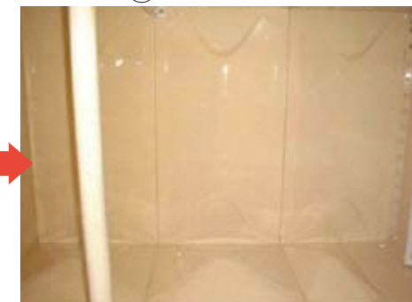
貯水槽清掃 (後)
